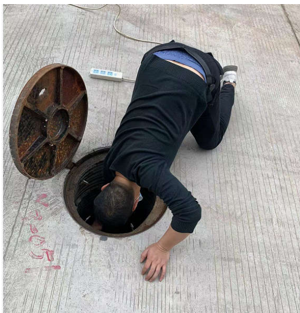
用挡板阻挡雨水口
