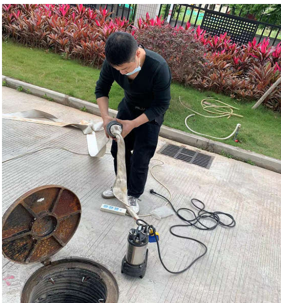
水泵放入雨水口，并接通管道
