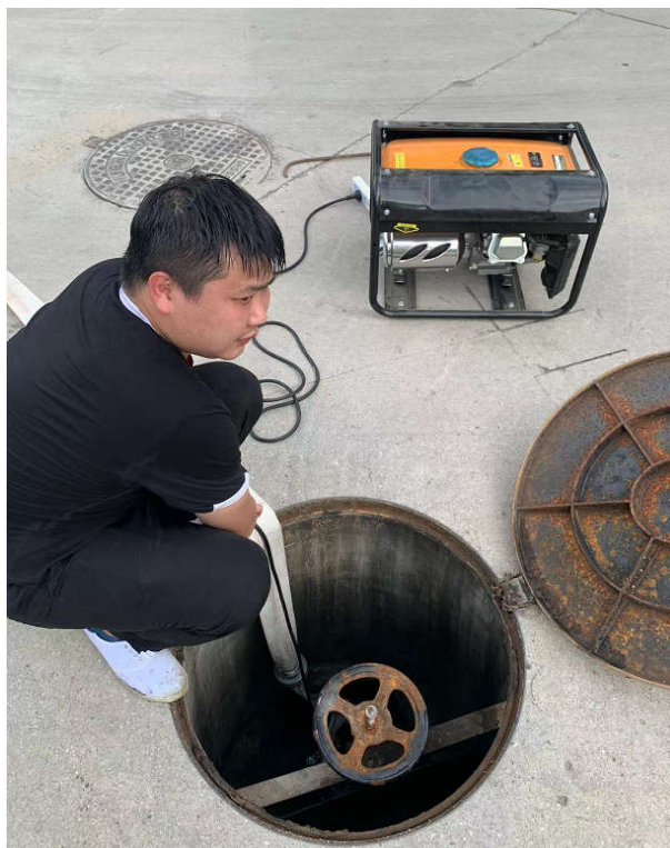
抽空雨水管道的水,并用自来水冲至 pH 呈中性
