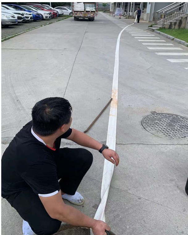
铺设抽水管至应急抽水管
