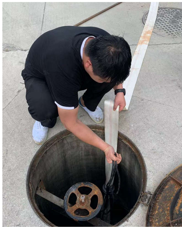
雨水闸阀口放置抽水泵
